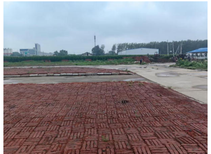
厂区南侧情况
