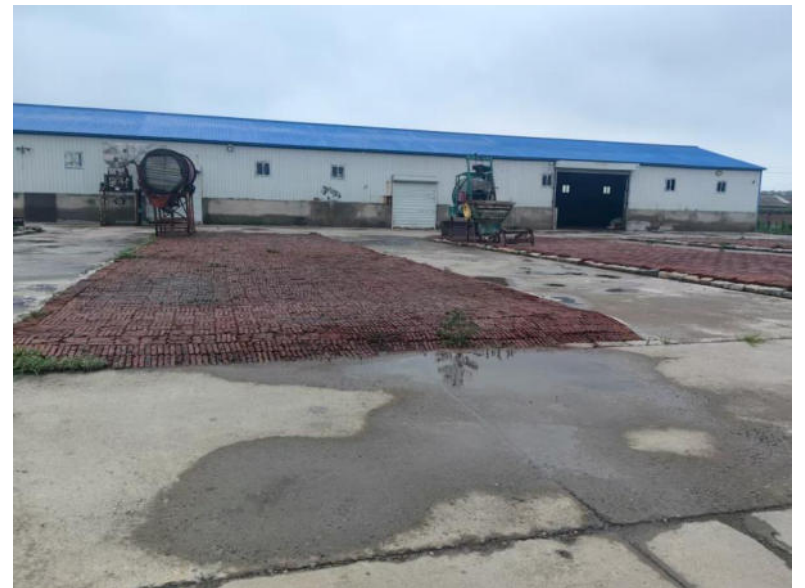
厂区北侧情况
