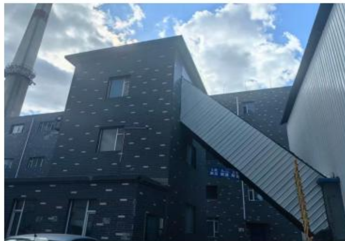
现有锅炉房及排气筒
