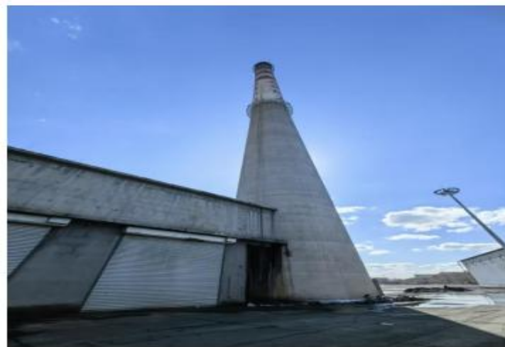
现有锅炉排气筒
